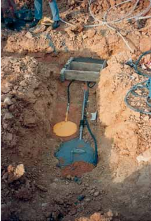
Ejecución de elementos de auscultación
